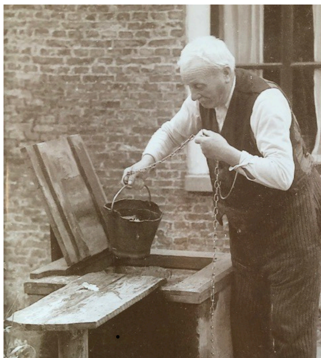
Aanleg van de Waterleiding op Schiermonnikoog
